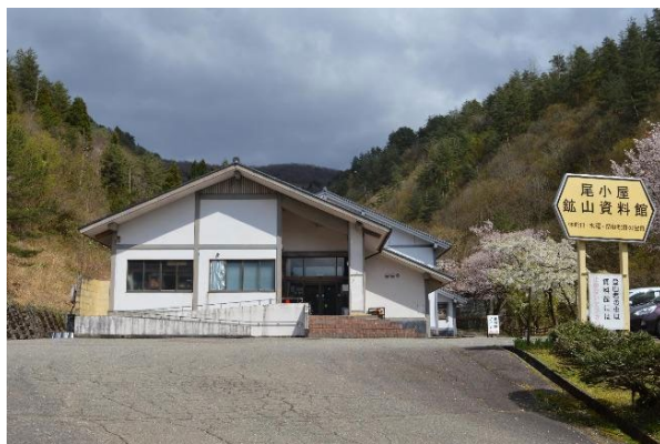
尾小屋鉱山資料館外観
